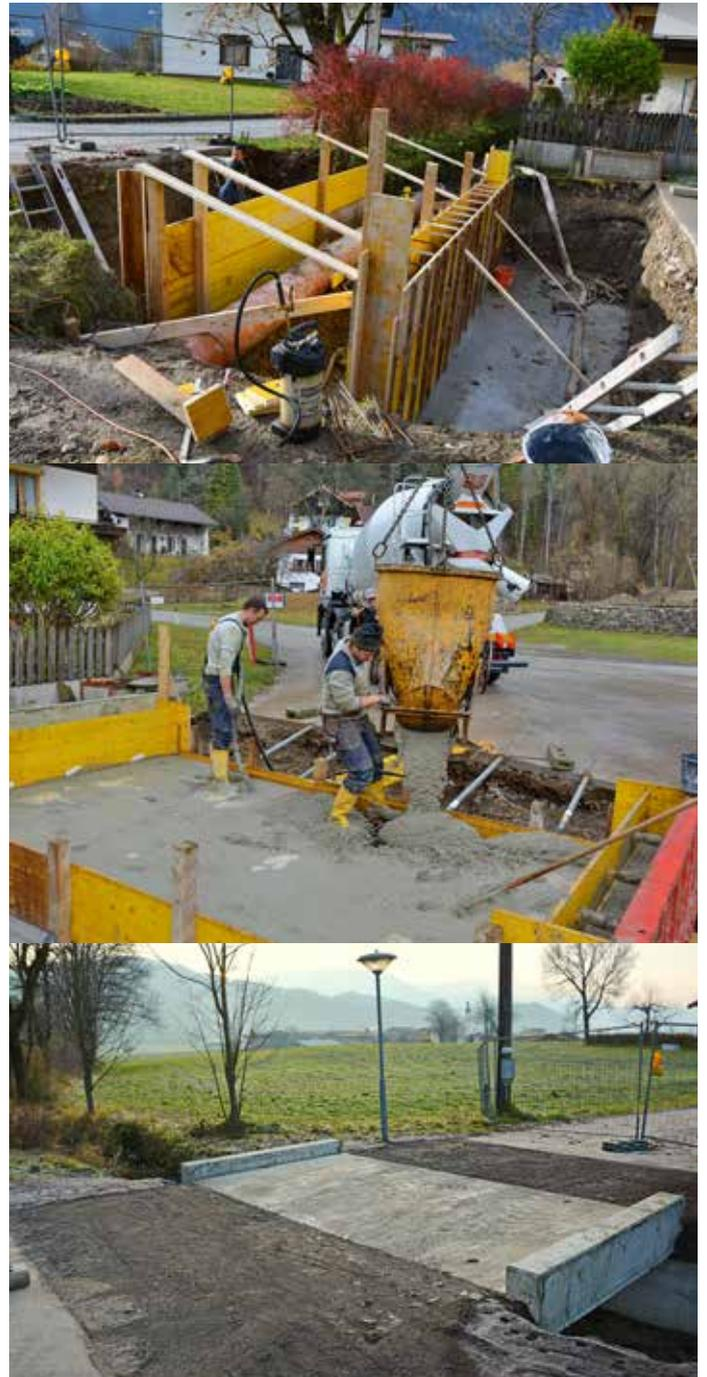
Der alte Weiderost im Bereich Zufahrt zum Recyclinghof auf Höhe des Anwesens „Bacher“ hatte schon lange ausgedient. Ende 2019 konnte dieser nun endlich ausgebaut und durch eine neue Brücke ersetzt werden. Die starke Lärmbelastigung für die Anrainer gehört damit der Vergangenheit an und das freut mich. Ich bedanke mich bei der ausführenden Firma
