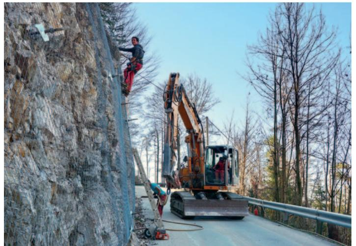
Bereits im November letzten Jahres konnten bei der Erlerbergstraße im Bereich „Grundner Mühle“ dringende Hangsicherungsarbeiten durchgeführt werden. Aufgrund freier Auftragskapazitäten bei der Firma HTB-Spezialtiefbau konnte nunmehr Ende März ein weiteres Teilstück der Erlerberg-
